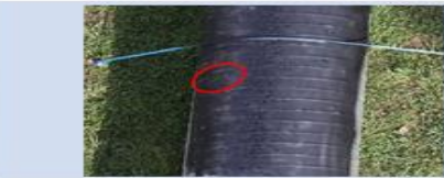
Conduite Forcée (ligne de rouille)
